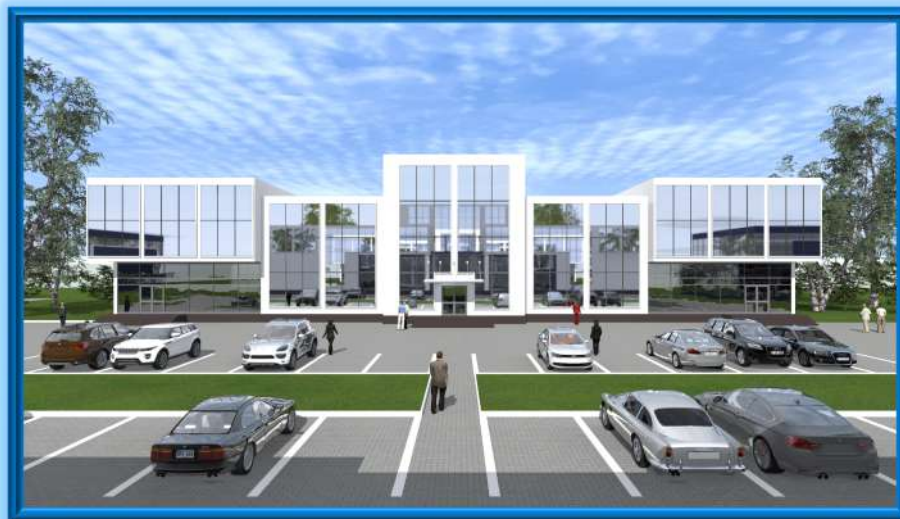
Главное научно-производственное здание.
