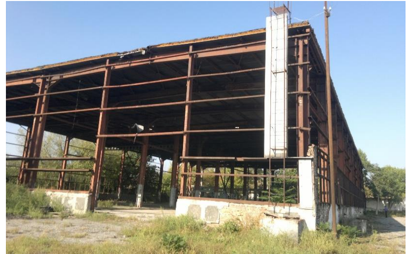
Здание из ЛМК (36x60м) для сборки контейнерных СНЭ
