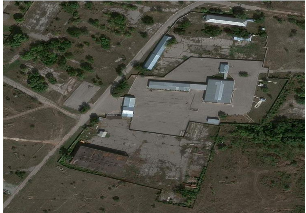
Вид завода из космоса
