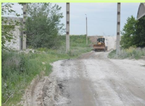
Подготовка основания для проведения работ
