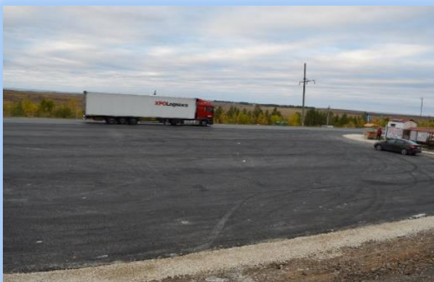
На уплотненный щебень наносится асфальтобетонная смесь
