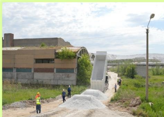
Разравнивание фосфогипса дорожного
