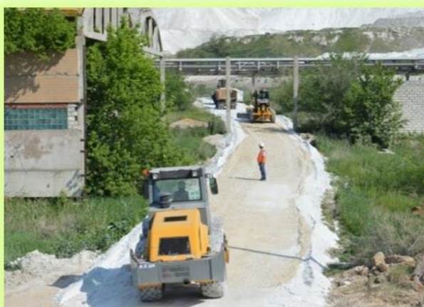
Распределение и уплотнение щебня на слой фосфогипса
